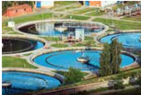
Statii de tratare ape uzate
