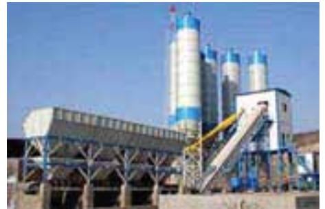
Statii de betoane si asfalt
